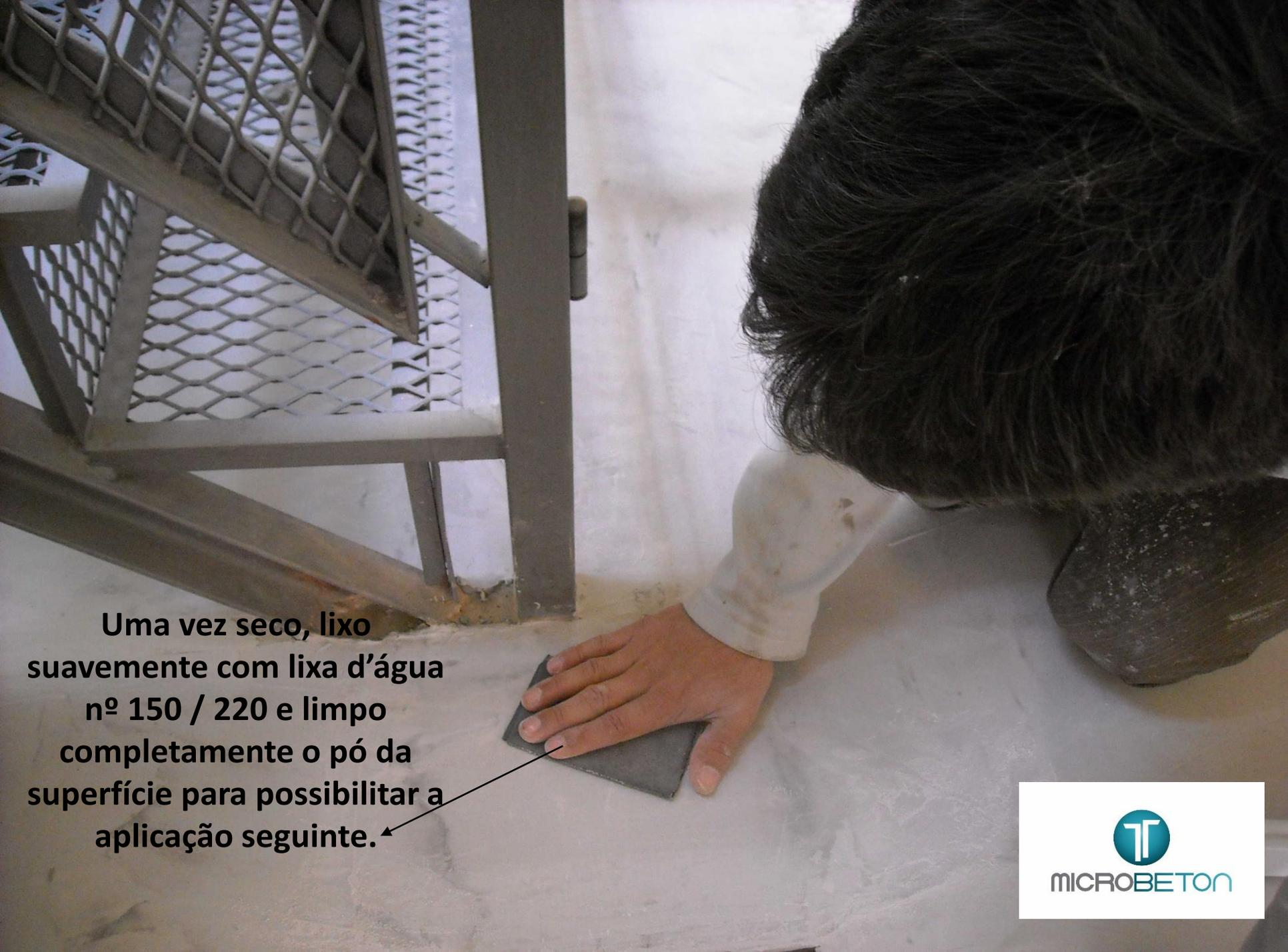
**Uma vez seco, lixó suavemente com lixa d'água nº 150 / 220 e limpo completamente o pó da superfície para possibilitar a aplicação seguinte.**
