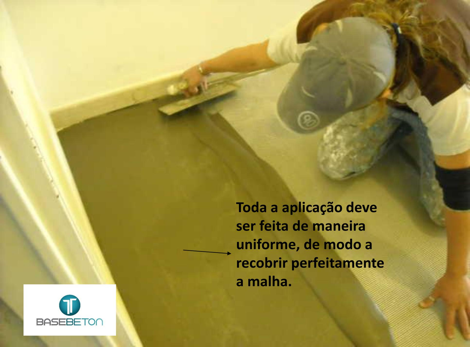
**Toda a aplicação deve ser feita de maneira uniforme, de modo a recobrir perfeitamente a malha.**
